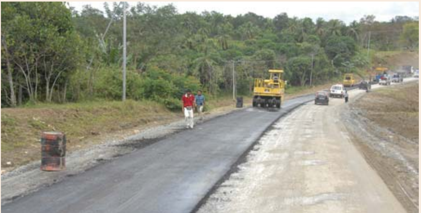
Proses pembinaan jalan luar bandar.
