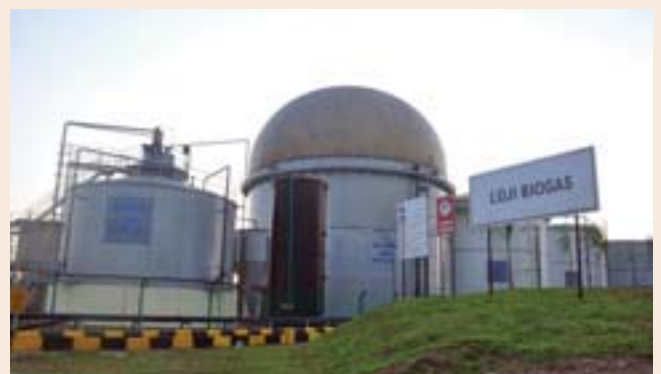
Loji biogas menyumbang kepada sumber bekalan elektrik negara.
