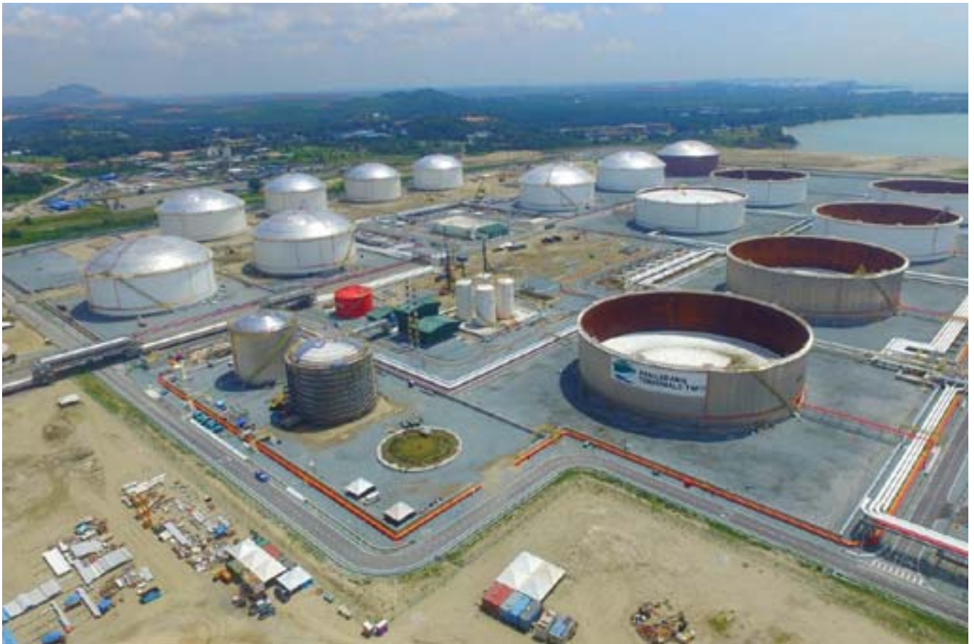
Fasa Kedua Terminal Petroleum Perairan Dalam Pengerang (PDT) akan menambah 2.1 juta m 3 kepada kapasiti sedia ada di Pengerang.
